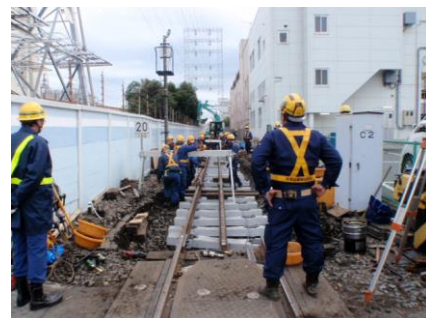
千鳥線レール、マクラギ、 道床交換工事
