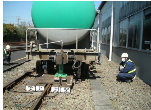
脱線した貨車を持ち上げて横移動し、レール上に載線させる貨車の脱線復旧訓練
